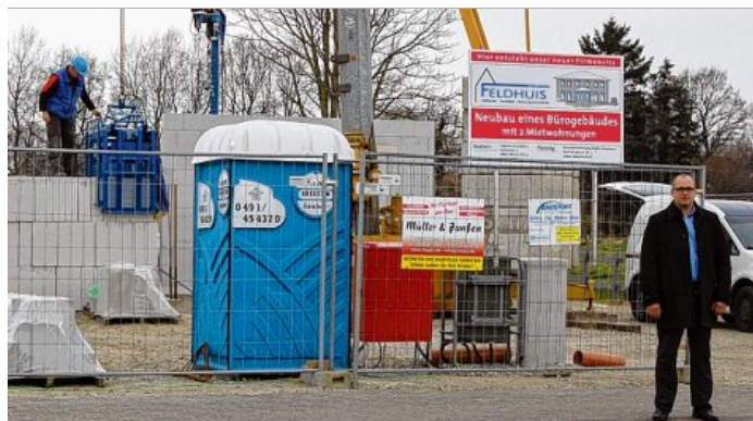
Auktionator Ingo Kroon (rechts) an der Baustelle für sein neues Bürogebäude an der Koloniestraße. BILD: LÜPPEN
